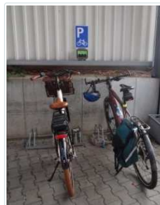
Für die Elektro-Job-Bikes der Mitarbeiter wurde eine Ladestelle installiert. (Bildquelle: Simone Fischer/Redaktion Plastverarbeiter)
